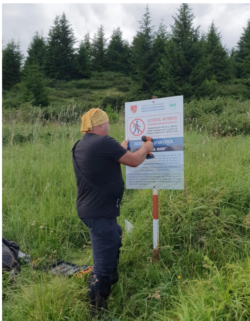
Imagine 56 intervenție pentru curățarea infrastructurii distruse și înlocuirea, reparația panourilor de informare
