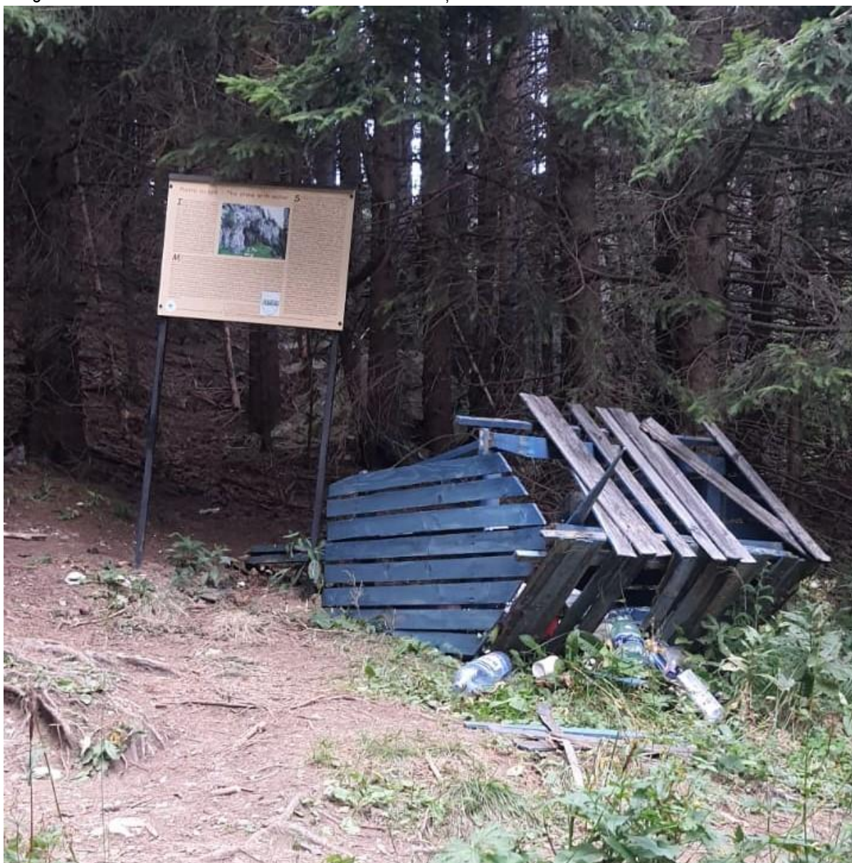
Imagine 58 Infrastructură vizitare care a necesitat intervenții
